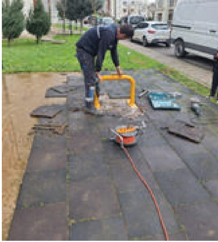
Parklarımızın bakım onarımlarının yapılması
