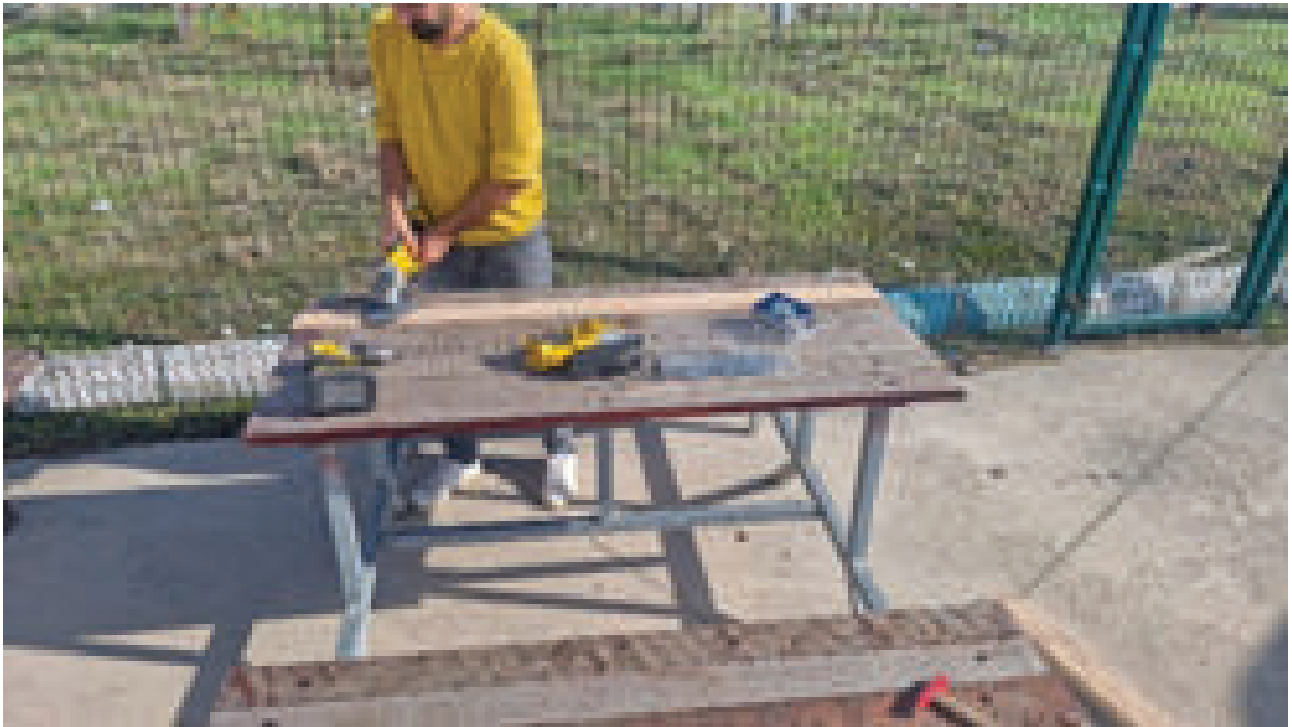
Ahşap oturma ekipmanlarının bakım onarımlarının yapılması
